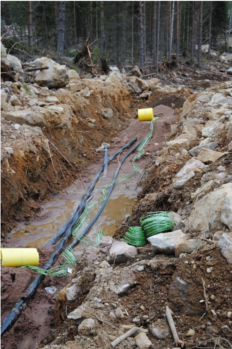
Figur 11. Kabelgrav med kabel och kommunikationsnät intill väg. Foto: Erik Aretorn.
