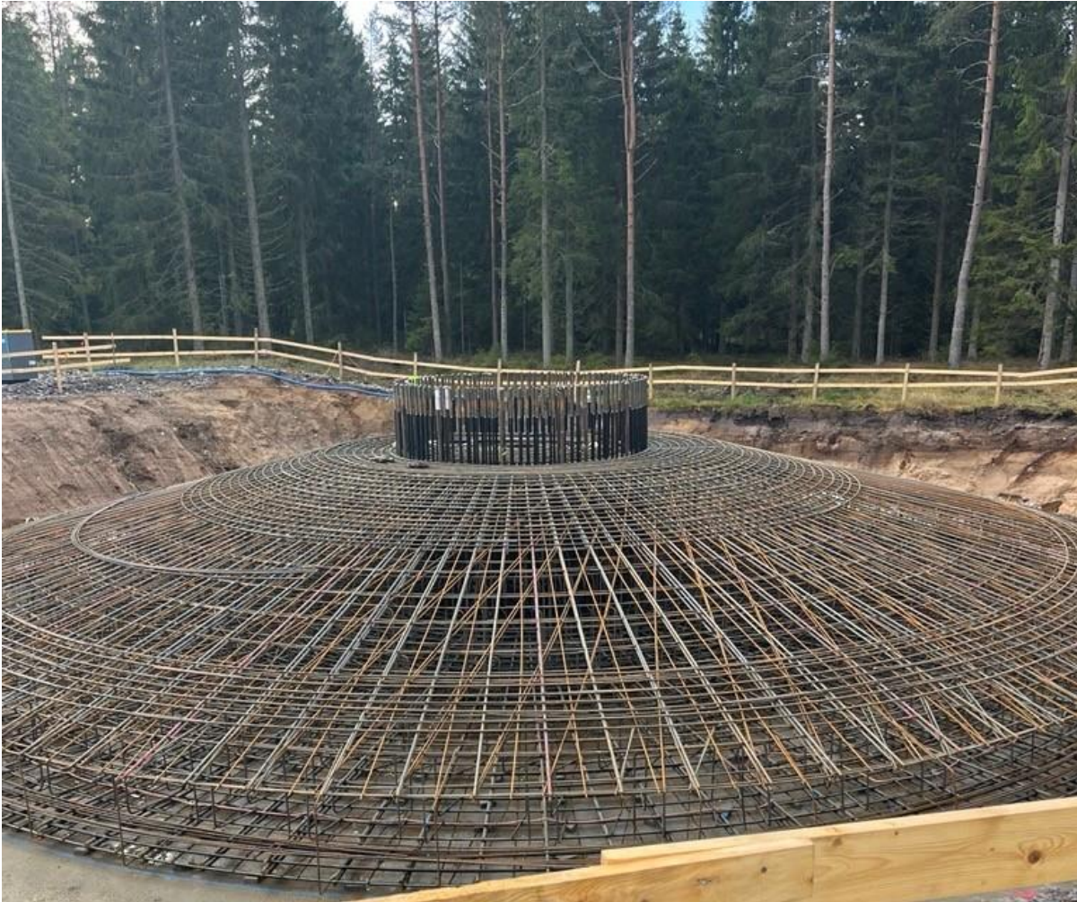
Figur 7. Gravitationsfundament. Foto: WSP Sverige AB.
