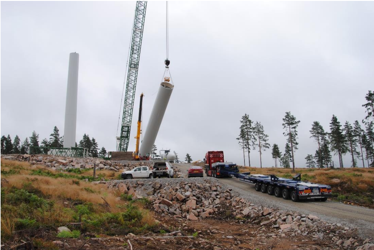
Figur 14. Montering av vindkraftverk. Foto: Erik Aretorn.
